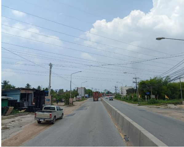
รูปก่อนการก่อสร้าง กม.ที่ ๘+๑๐๐
