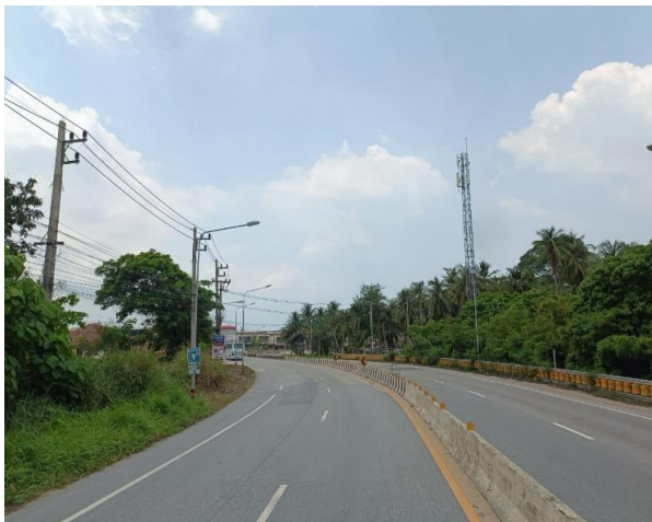
รูปก่อนการก่อสร้าง กม.ที่ ๖+๘๐๐
