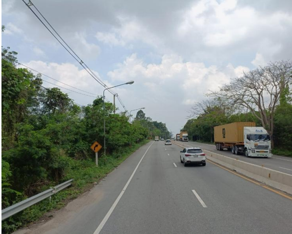
รูปก่อนการก่อสร้าง กม.ที่ ๓+๙๐๐
