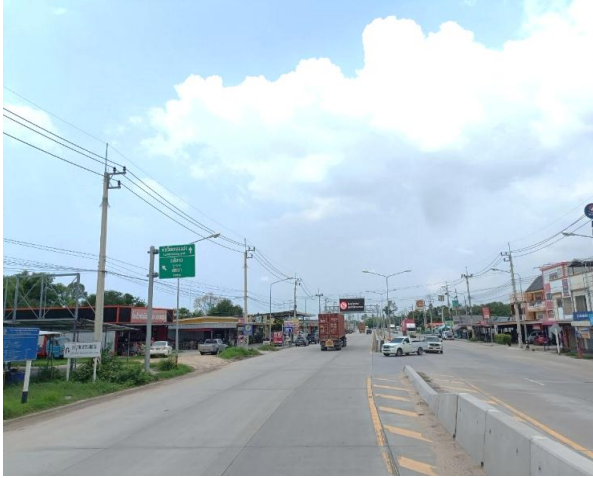
รูปก่อนการก่อสร้าง กม.ที่ ๘+๓๑๗.๖๐๑ (จุดสิ้นสุดโครงการ)
