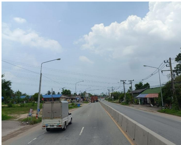
รูปก่อนการก่อสร้าง กม.ที่ ๘+๐๐๐
