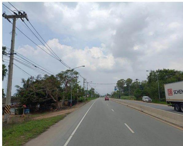
รูปก่อนการก่อสร้าง กม.ที่ ๔+๘๐๐
