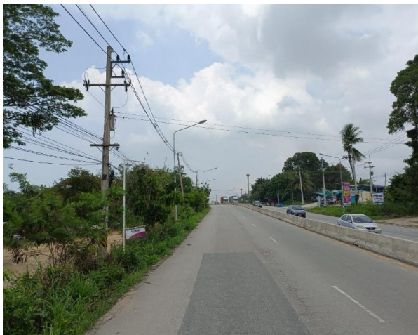
รูปก่อนการก่อสร้าง กม.ที่ ๖+๐๐๐
