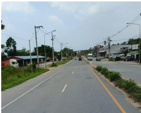
รูปก่อนการก่อสร้าง กม.ที่ ๗+๔๐๐
