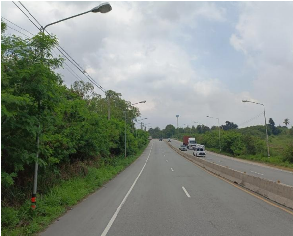
รูปก่อนการก่อสร้าง กม.ที่ ๔+๕๐๐
