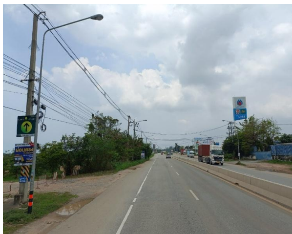
รูปก่อนการก่อสร้าง กม.ที่ ๕+๐๐๐
