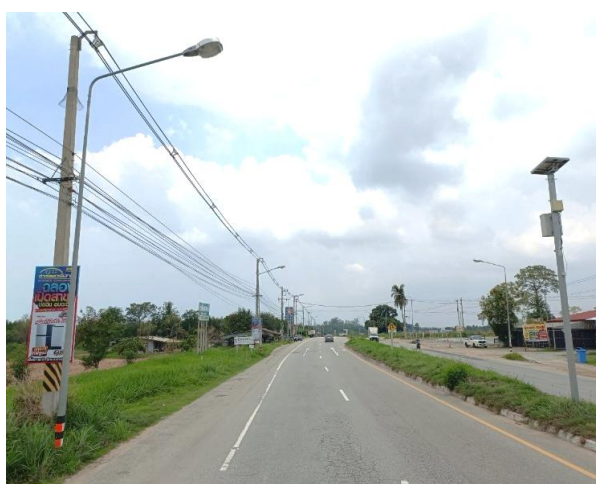
รูปก่อนการก่อสร้าง กม.ที่ ๕+๒๐๐
