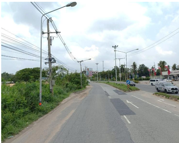
รูปก่อนการก่อสร้าง กม.ที่ ๕+๘๐๐
