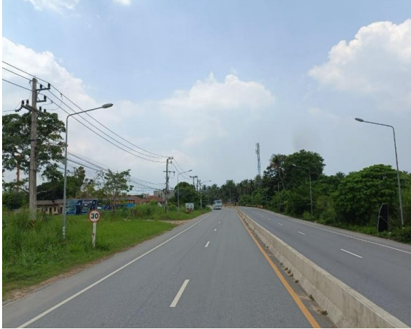
รูปก่อนการก่อสร้าง กม.ที่ ๖+๗๐๐
