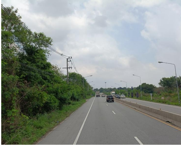
รูปก่อนการก่อสร้าง กม.ที่ ๔+๓๐๐
