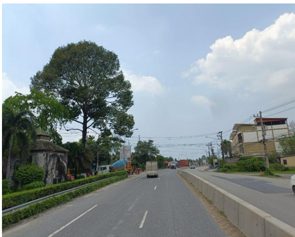
รูปก่อนการก่อสร้าง กม.ที่ ๗+๘๐๐
