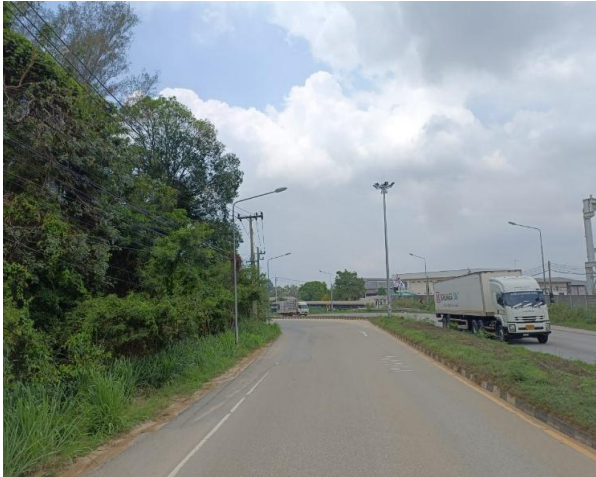
รูปก่อนการก่อสร้าง กม.ที่ ๖+๓๐๐
