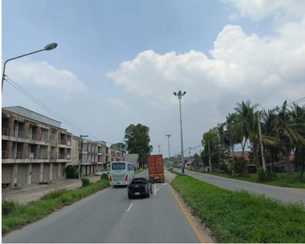
รูปก่อนการก่อสร้าง กม.ที่ ๗+๑๐๐
