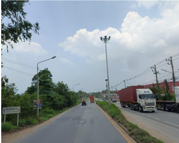
รูปก่อนการก่อสร้าง กม.ที่ ๗+๓๐๐
