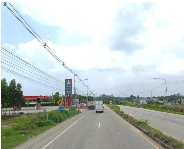
รูปก่อนการก่อสร้าง กม.ที่ ๕+๔๐๐
