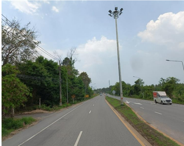
รูปก่อนการก่อสร้าง กม.ที่ ๖+๕๐๐
