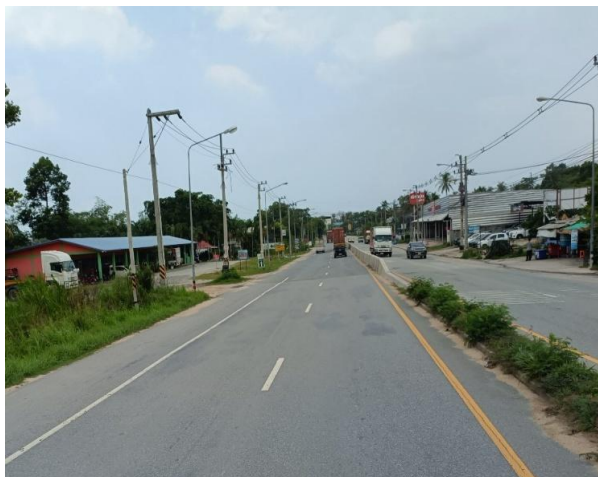
รูปก่อนการก่อสร้าง กม.ที่ ๗+๔๐๐
