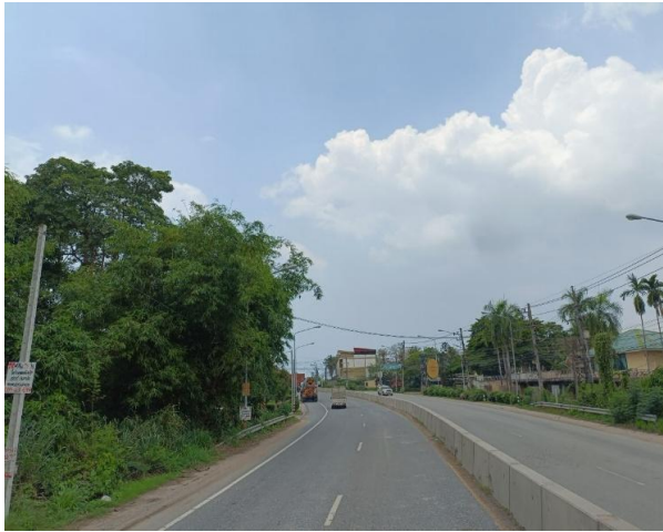
รูปก่อนการก่อสร้าง กม.ที่ ๗+๗๐๐
