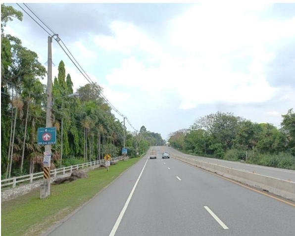
รูปก่อนการก่อสร้าง กม.ที่ ๓+๘๐๐
