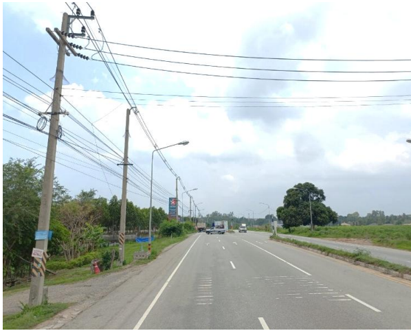
รูปก่อนการก่อสร้าง กม.ที่ ๕+๓๐๐
