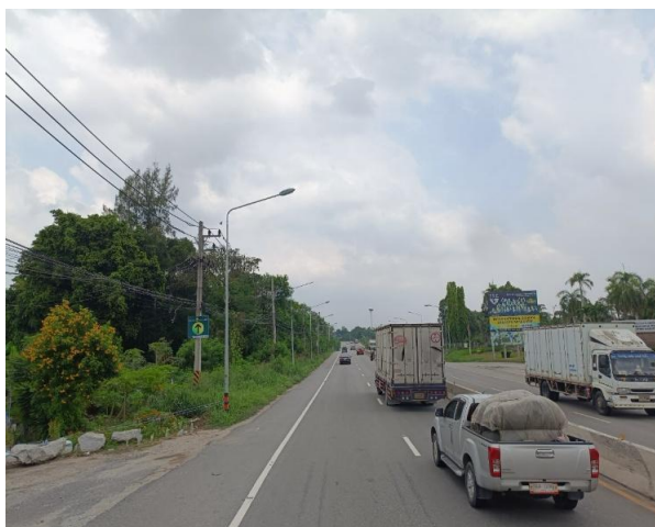
รูปก่อนการก่อสร้าง กม.ที่ ๔+๒๐๐
