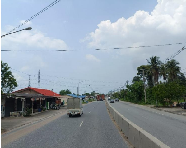
รูปก่อนการก่อสร้าง กม.ที่ ๗+๙๐๐
