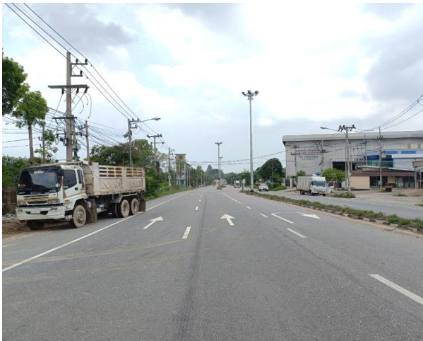
รูปก่อนการก่อสร้าง กม.ที่ ๓+๕๐๐ (จุดเริ่มต้นโครงการ)
