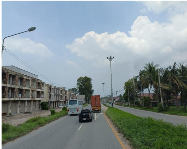
รูปก่อนการก่อสร้าง กม.ที่ ๗+๑๐๐
