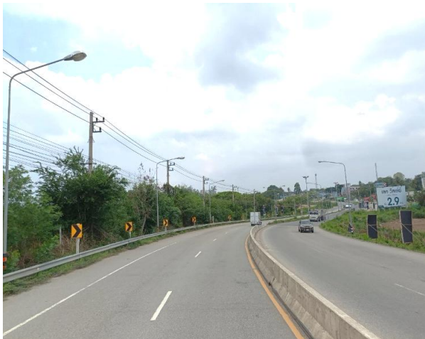
รูปก่อนการก่อสร้าง กม.ที่ ๕+๖๐๐
