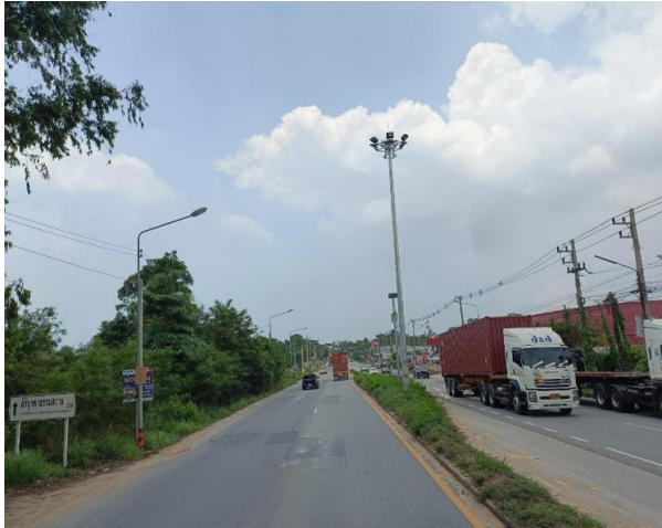
รูปก่อนการก่อสร้าง กม.ที่ ๗+๓๐๐
