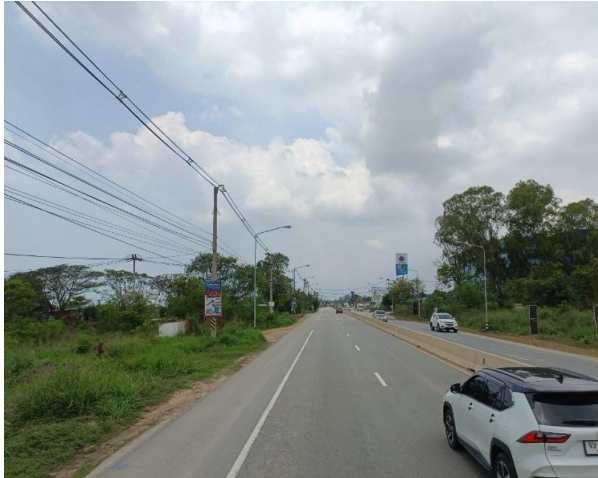
รูปก่อนการก่อสร้าง กม.ที่ ๔+๙๐๐
