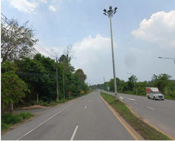
รูปก่อนการก่อสร้าง กม.ที่ ๖+๕๐๐
