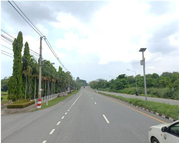
รูปก่อนการก่อสร้าง กม.ที่ ๓+๗๐๐
