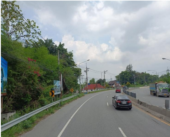
รูปก่อนการก่อสร้าง กม.ที่ ๔+๑๐๐
