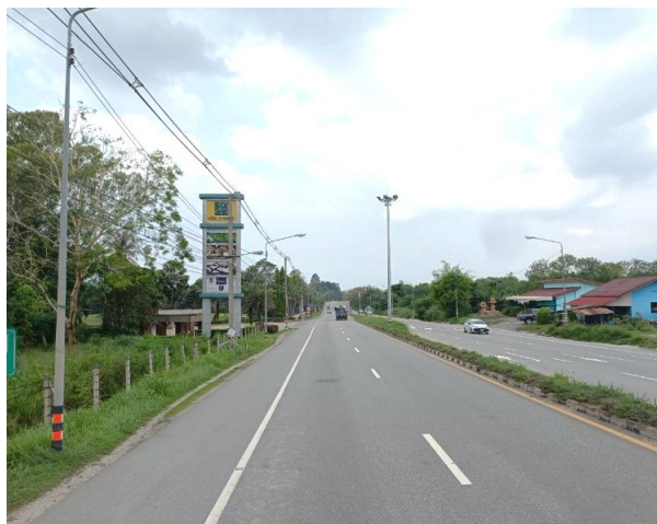
รูปก่อนการก่อสร้าง กม.ที่ ๓+๖๐๐
