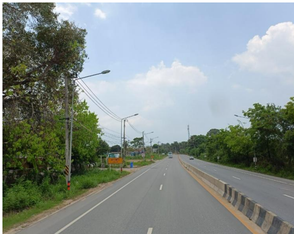
รูปก่อนการก่อสร้าง กม.ที่ ๖+๖๐๐
