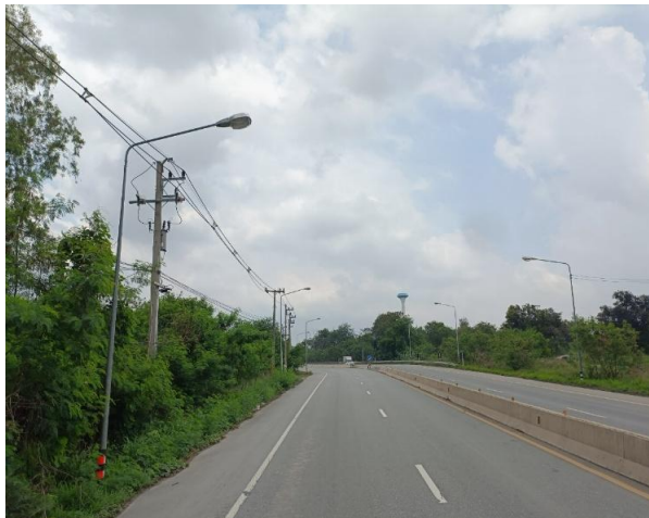
รูปก่อนการก่อสร้าง กม.ที่ ๔+๖๐๐
