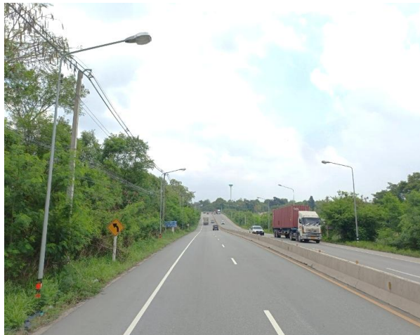
รูปก่อนการก่อสร้าง กม.ที่ ๔+๔๐๐
