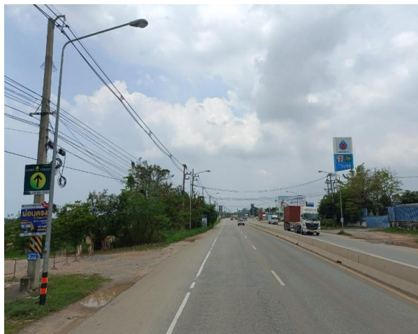
รูปก่อนการก่อสร้าง กม.ที่ ๕+๐๐๐
