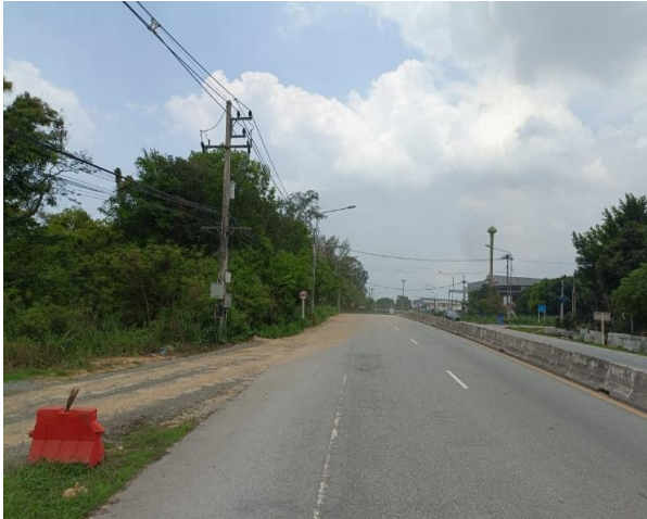
รูปก่อนการก่อสร้าง กม.ที่ ๖+๑๐๐
