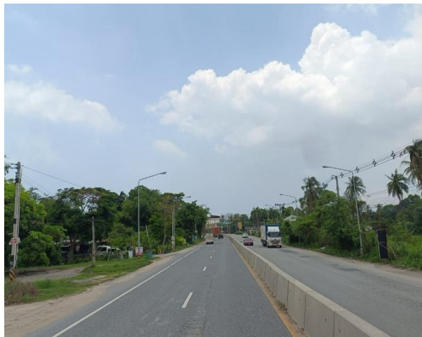
รูปก่อนการก่อสร้าง กม.ที่ ๗+๖๐๐
