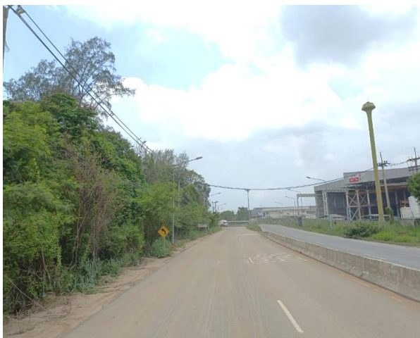
รูปก่อนการก่อสร้าง กม.ที่ ๖+๒๐๐
