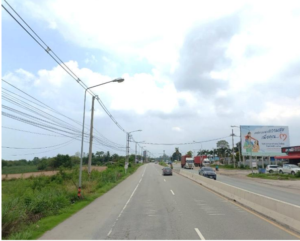
รูปก่อนการก่อสร้าง กม.ที่ ๕+๑๐๐
