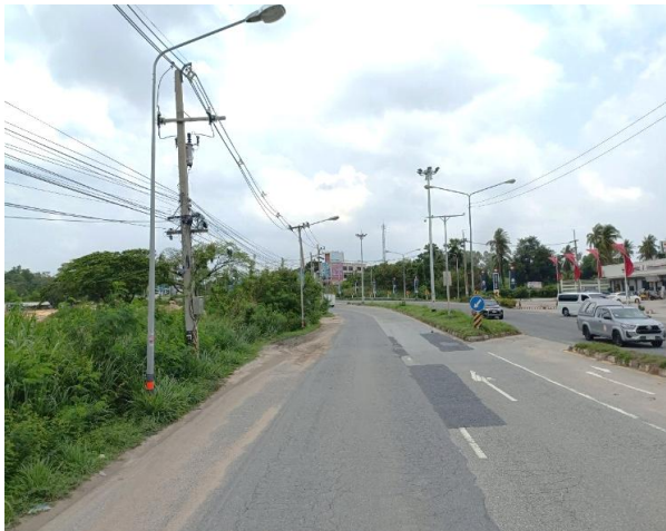
รูปก่อนการก่อสร้าง กม.ที่ ๕+๘๐๐
