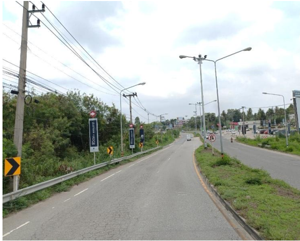
รูปก่อนการก่อสร้าง กม.ที่ ๕+๗๐๐
