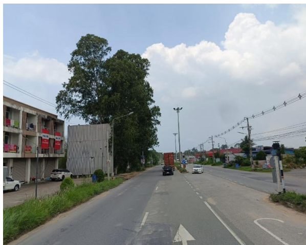
รูปก่อนการก่อสร้าง กม.ที่ ๗+๒๐๐
