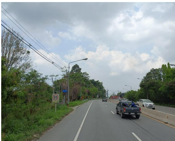
รูปก่อนการก่อสร้าง กม.ที่ ๔+๐๐๐
