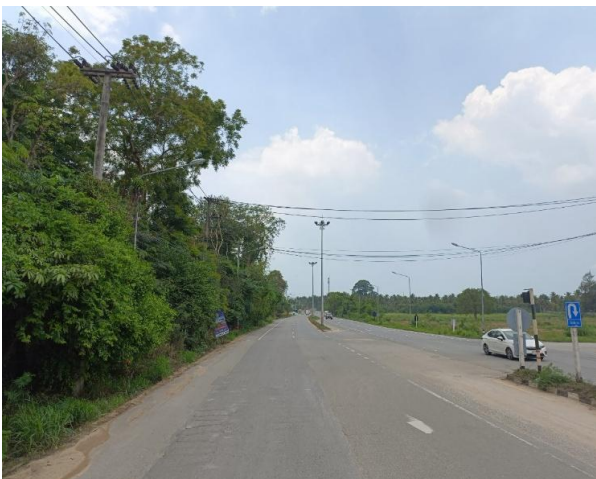
รูปก่อนการก่อสร้าง กม.ที่ ๖+๔๐๐
