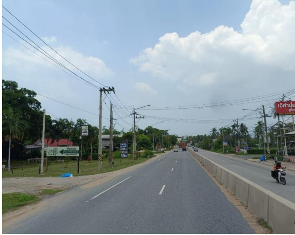
รูปก่อนการก่อสร้าง กม.ที่ ๗+๕๐๐
