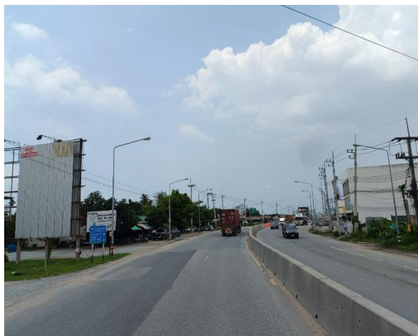
รูปก่อนการก่อสร้าง กม.ที่ ๘+๒๐๐
